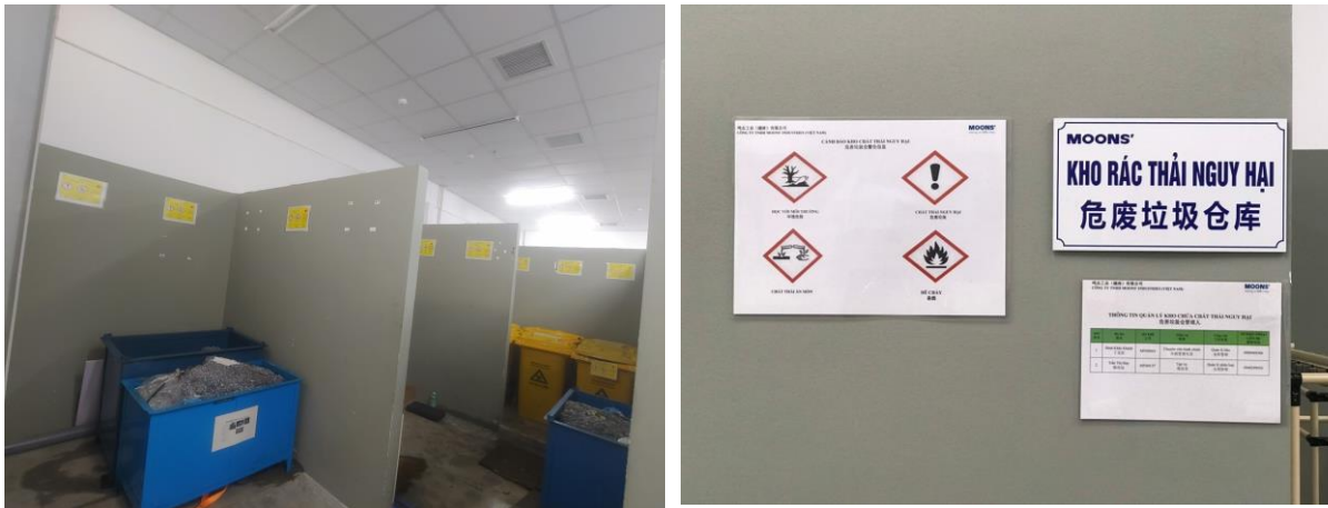
Hình 1.13. Kho chất thải nguy hại của nhà máy hiện hữu
