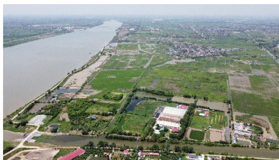
Một vài hình ảnh hiện trạng dự án
