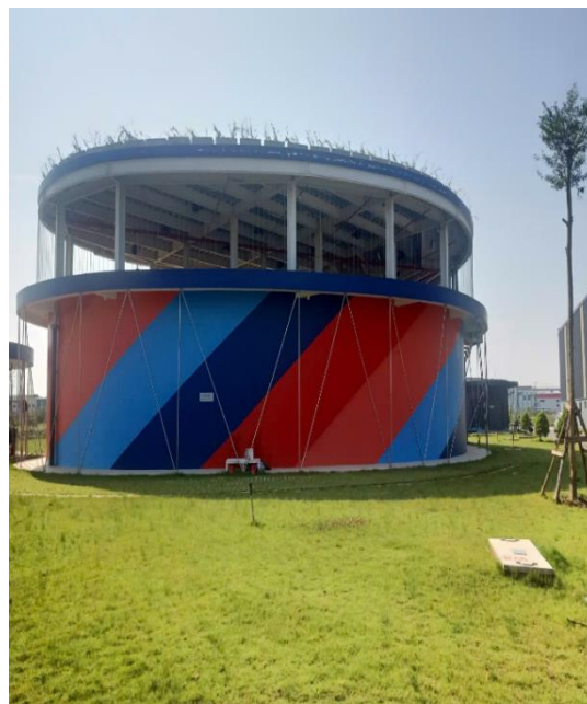
Bể nước PCCC tại lô CN2A
