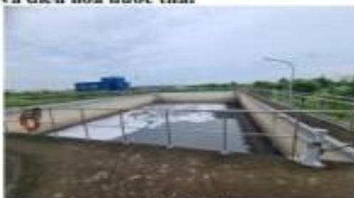
Bể điều hòa
