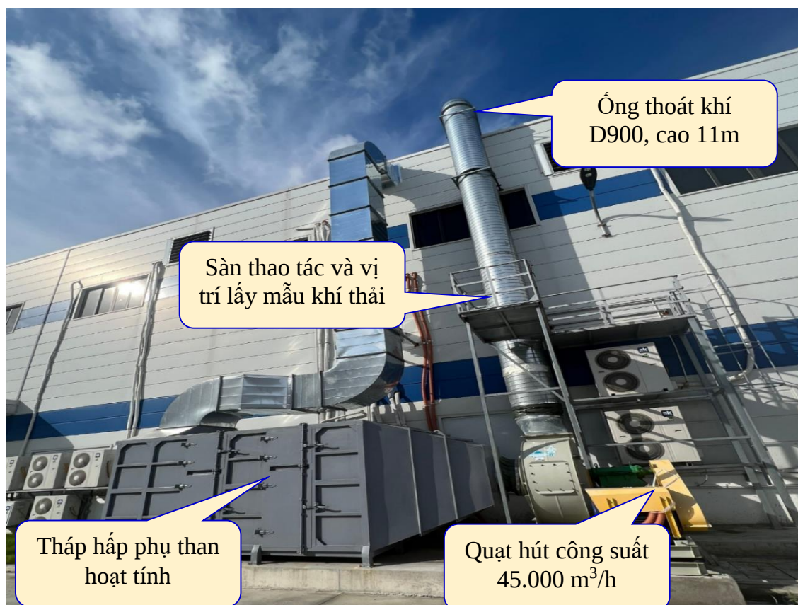
Hình 4. 12. Hình ảnh minh họa hệ thống xử lý khí thải từ chuyên sơn, sấy UV và dán đế
