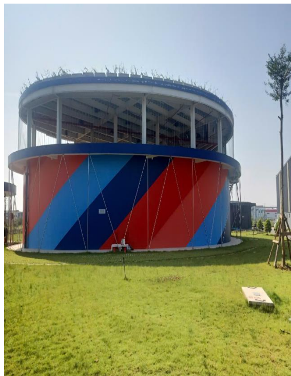
Bể nước PCCC tại lô CN2A
