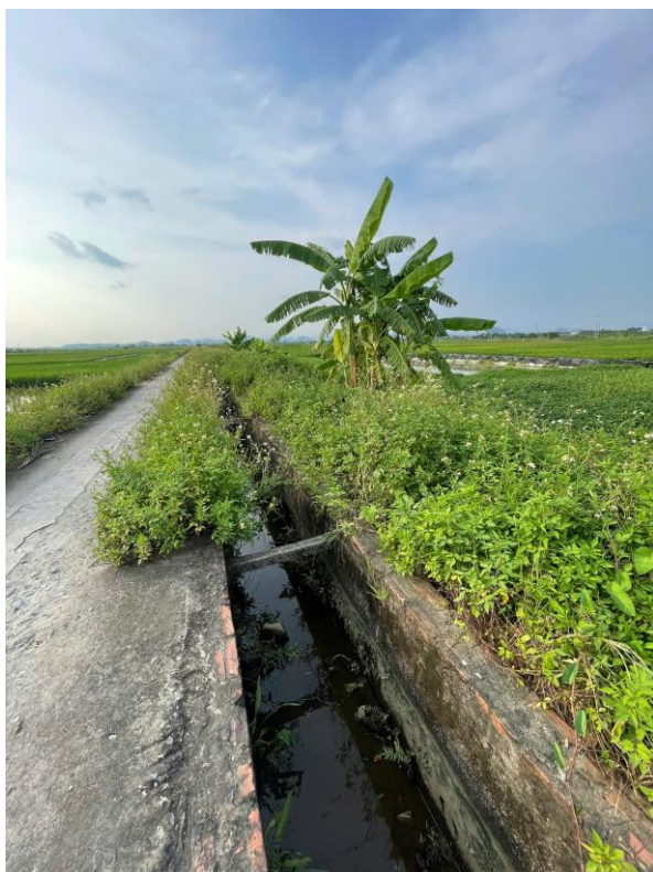
Đường bê tông nội đồng và kênh cứng Kc1-Tb Bến Chang
