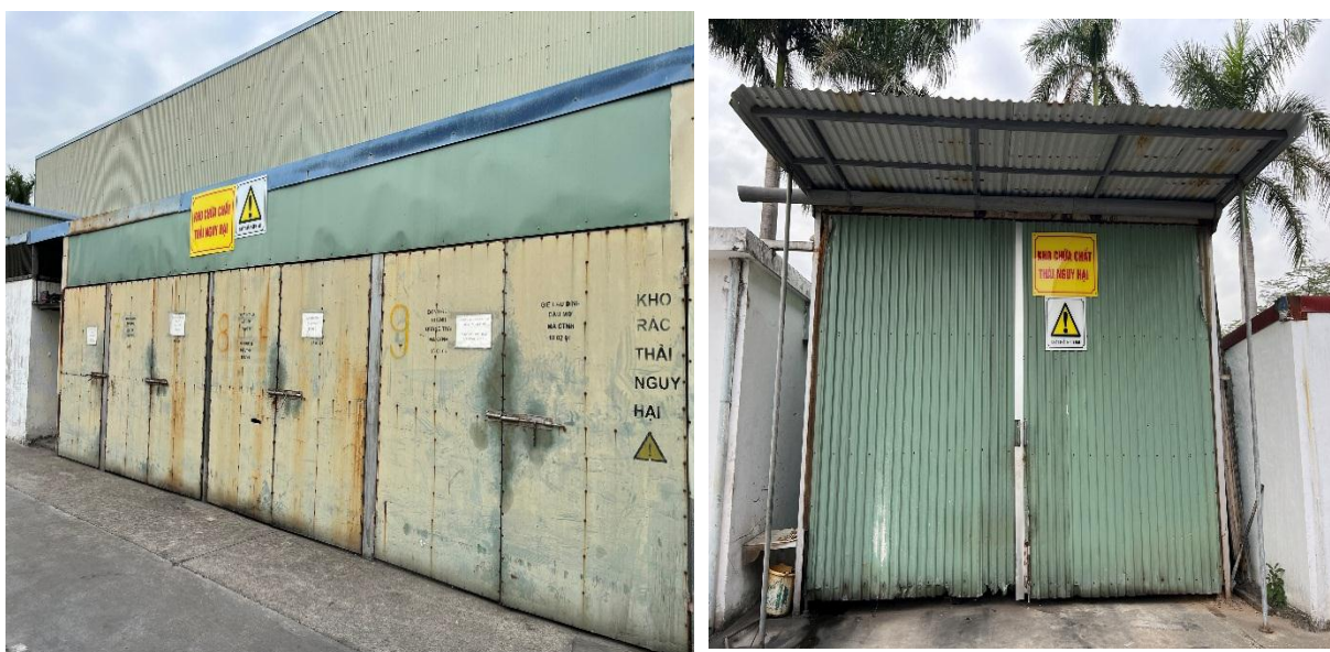
Hình 3.14. Hình ảnh kho lưu giữ CTNH của Công ty
