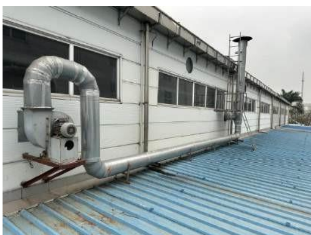
Hình ảnh ống thoát khí chung của hai khu vực
