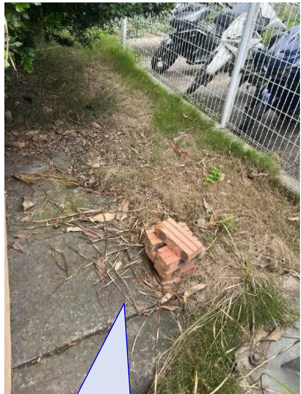
Điểm thoát nước mưa 2 X(m): 2306972, Y(m): 584915
