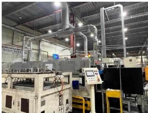
Hình ảnh hệ thống thu gom khí thải từ thiết bị rửa linh kiện sau dập
