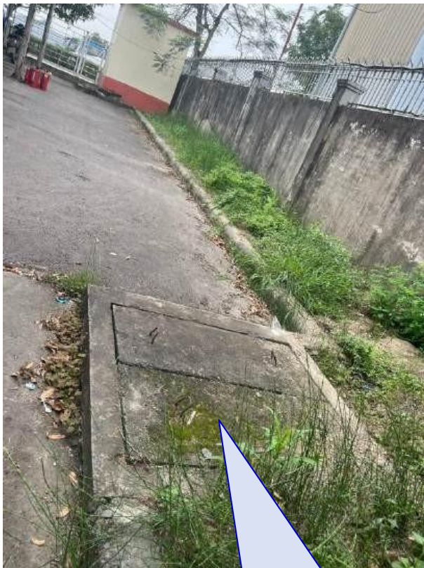
Điểm thoát nước mưa 1 X(m): 2306866, Y(m): 584831
