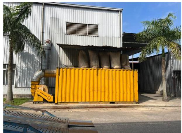
Hệ thống thu gom khí thải từ các thiết bị phát sinh để dẫn về hệ thống thu bụi số 09
