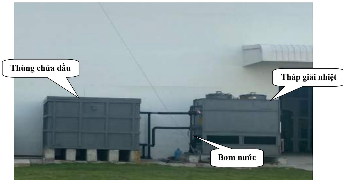
Hình 3.4. Hình ảnh hệ thống thu gom, làm mát dầu từ quá trình nhiệt luyện
