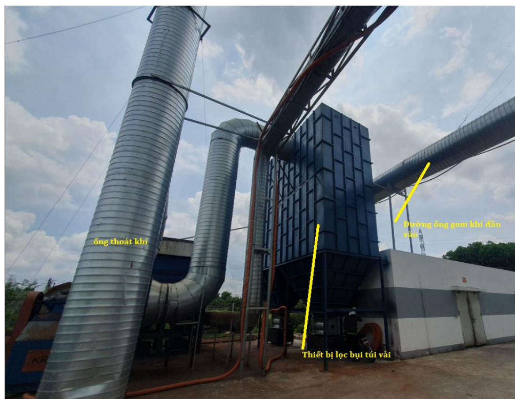
Hình 4.3. Hệ thống xử lý bụi khu vực gia công đĩa phanh (tham khảo Công ty TNHH chế tạo máy Yuekai (Thửa C-16, Lô đất CN9 bên cạnh, đây là Công ty cùng tập đoàn để sản xuất phôi đĩa phanh ô tô)
