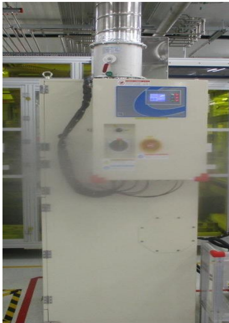
Hình 3- 6: Hình ảnh thiết bị lọc bụi máy laser cutting
